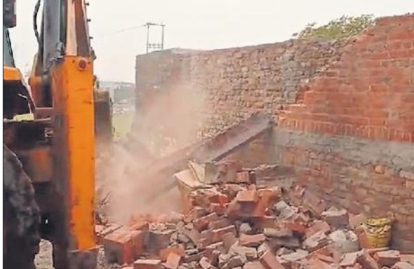
बहेड़ी में पक्के निर्माण को गिराता बुलडोजर।
