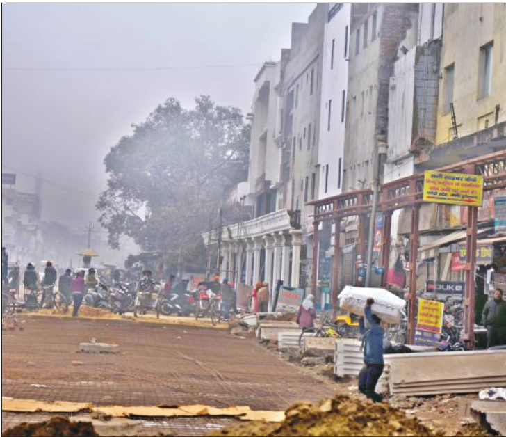
बुध बाजार में चल रहा सड़क निर्माण का कार्य।
