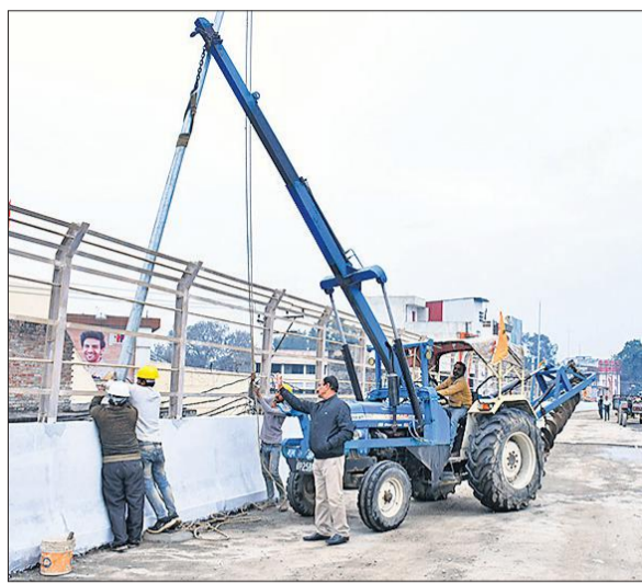
निर्माणाधीन कुतुबखाना पुल पर लगाये जा रहे खंभे।
