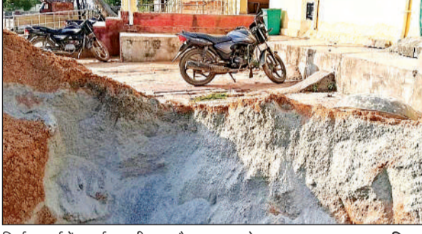
निर्माण कार्य में लगाई जा रही बालू और डस्ट लगा ढेर।
