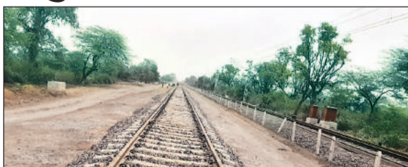
पुलिया निर्माण में लगी मशीन व बिछाई जा रही रेल पट्टरी।
