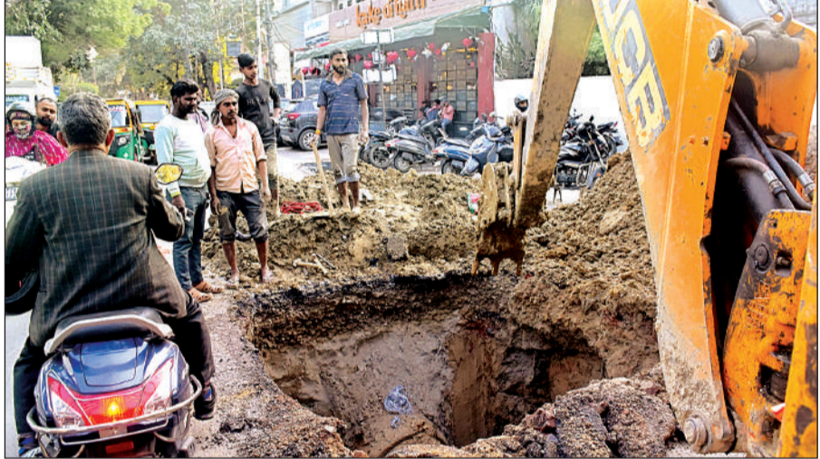
सर्वोदय नगर में पाइप लाइन लीकेज के कारण खोदाई की गई है।
