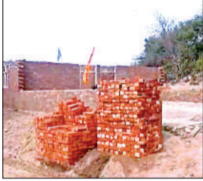
पुलिस द्वारा रुकवाया गया निर्माण।
