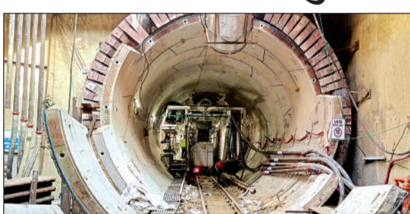
मेट्रो परियोजना में टनल निर्माण हो रहा है।
