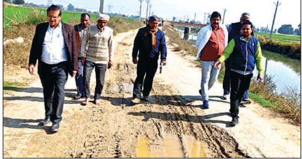
सड़क निर्माण के लिए ठेकेदार के साथ निरीक्षण करते जेई।
