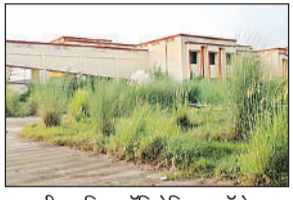
राजकीय महिला पॉलिटेक्निक कॉलेज का भवन। अमृत विचार
