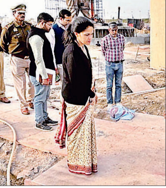
बसंत कुंज योजना स्थित प्रेरणास्थल के निर्माणार्थीन कार्यों का निरीक्षण करती मंडलायुक्त डॉ. रोशन जैकब, साथ में अन्य।
