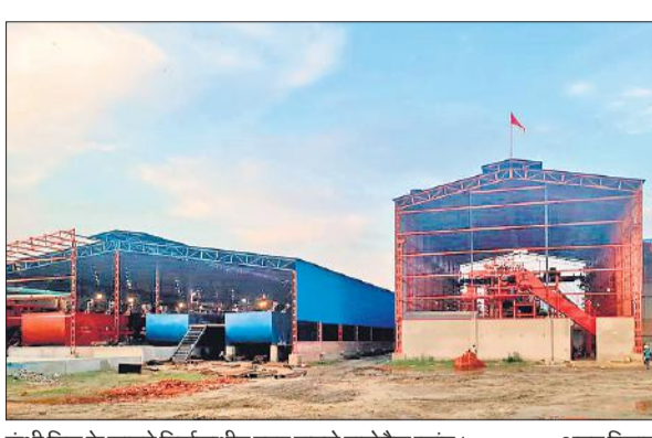
कुंभी मिल के सामने निर्माणाधीन एवन वाइरो बायोगैस प्लांट।
