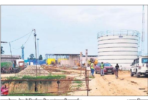
फूलबेहड़ क्षेत्र में निर्माणाधीन खांडसारी इकाई।
