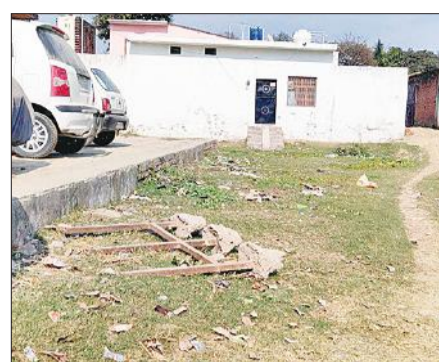
टूटे पड़ा डस्टबिन का स्टैंड।
