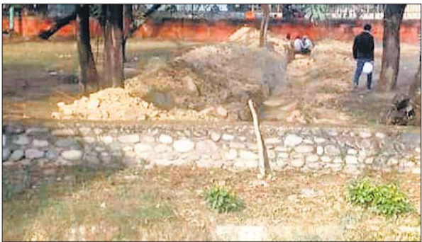
वन विभाग की जमीन पर निर्माण करा रहा इफको।
