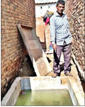
निर्माणाधीन टैंक दिखाता मृतका का पिता।
