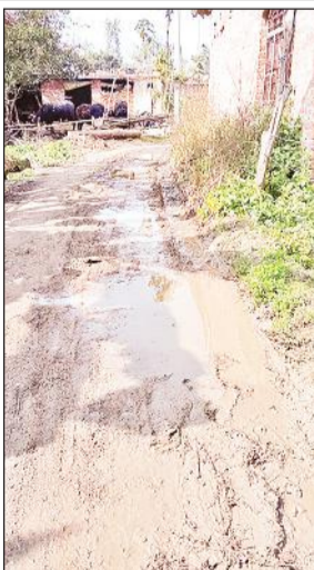
अटकोना में टूटी सड़क पर बह रहा पानी।
