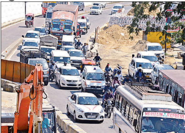
सहादतगंज बाईपास पर निर्माण के दौरान लगा जाम।
