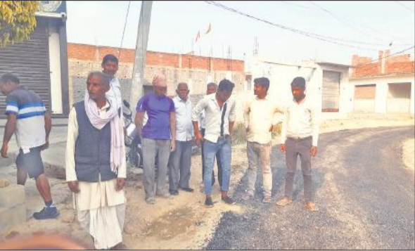
बिना धूल हटाए बनाई गई सड़क को दिखाते ग्रामीण।
