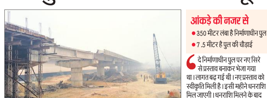
कैनाल बाइपास पर काली नदी पर निर्माणधीन पुल।
