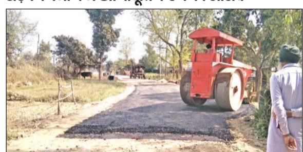
नानकमत्ता में सड़क निर्माण में जुटे श्रमिक।
