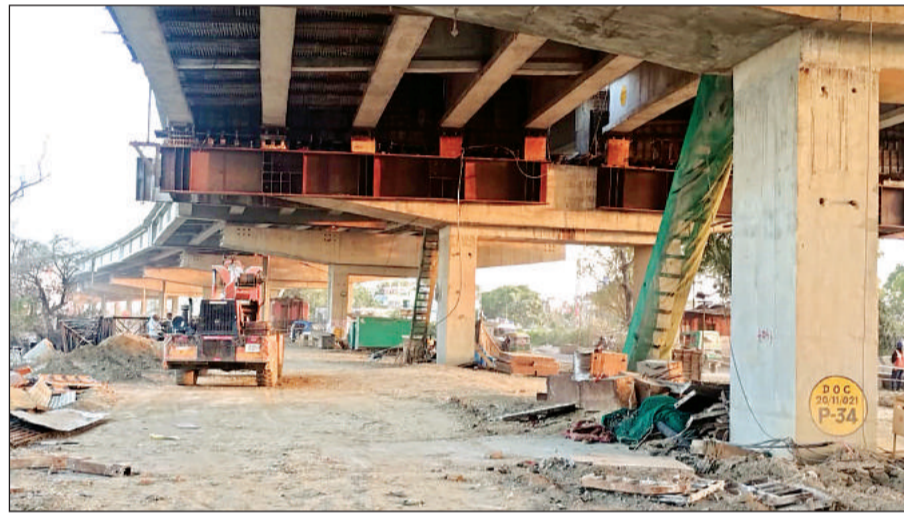
मंघना में बनाया जा रहा जीटी रोड का प्लाईओवर।
