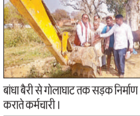
बांधा बैरी से गोलाघाट तक सड़क निर्माण कराते कर्मचारी।
