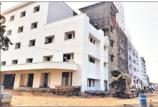
मेडिकल कॉलेज परिसर में निर्माणाधीन 200 बेड का अस्पताल।
