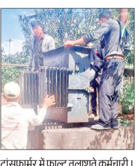
ट्रांसफार्मर में फाल्ट तलाशते कर्मचारी।
