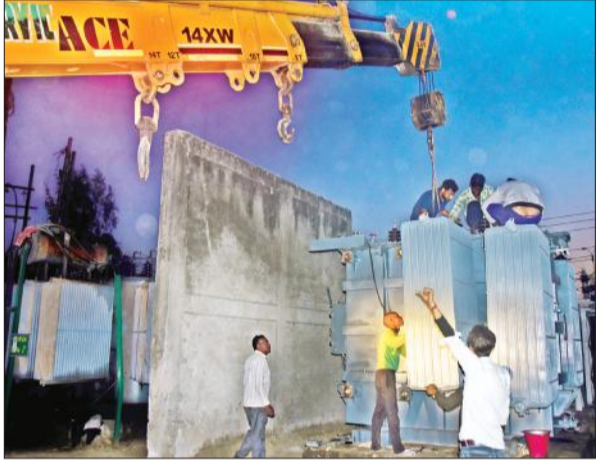
विवेकानंद विद्युत केंद्र पर नया ट्रांसफार्मर लगाते कर्मचारी।
