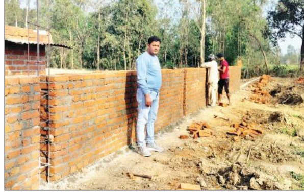
गांव दनकरा में हो रहा गोशाला का निर्माण।
