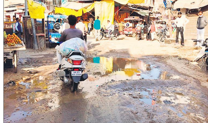
पचराहा पर पेयजल लाइन की मरम्मत के बाद भी हो रही लीकेज।
