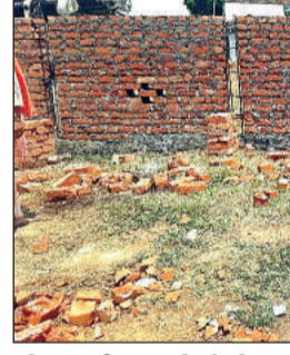
घंटिया बाउंड्रीवाल का निर्माण दिखाता ग्रामीण।
