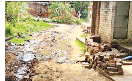
बिदोखर पुरई में खोदी गई सड़क पर भरा पानी।
