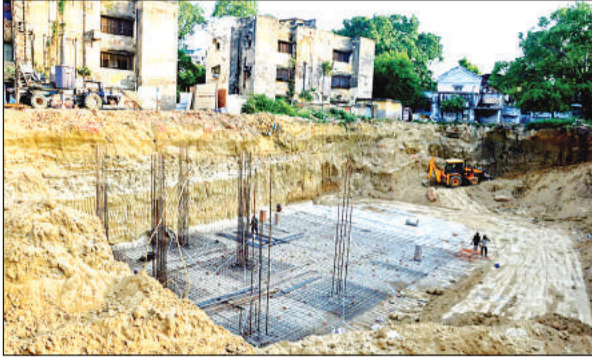
मल्टीलेवल पार्किंग का हो रहा निर्माण।
