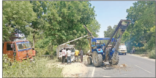
बिजली के पोल को हटकर लोडर निकालता ट्रैक्टर।
