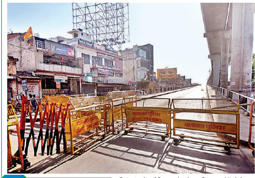
निशातगंज से आईटी तक जाने वाले पुल की मरम्मत होने को लेकर पुल को बंद किया गया।
