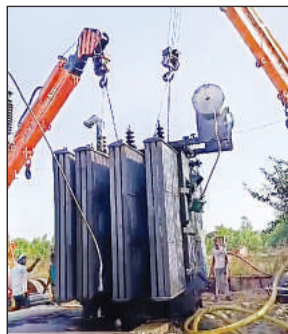
बिशनपुर विद्युत उपकेंद्र पर उतारा जा रहा अधिक क्षमता वाला नया ट्रांसफार्मर।
