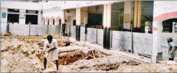
चन्दौसी के रेलवे स्टेशन पर पाकिंग का निर्माण करते मजदूर।
