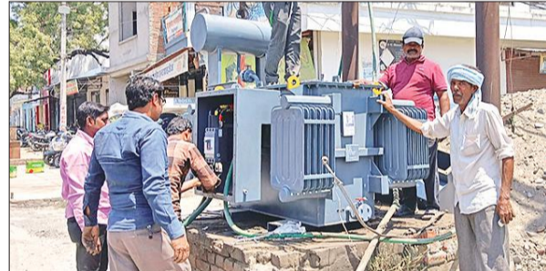
पूरनपुर की पंकज कॉलोनी में नया ट्रांसफार्मर लगाते कर्मचारी।
