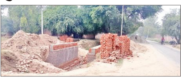
बिलसंडा की करेली माइनर पर निर्माणाधीन पुलिया।
