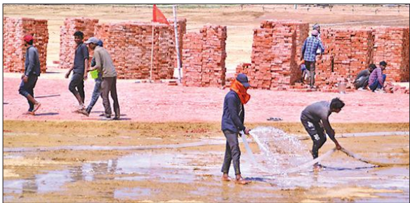
शहर से सटे मोमिनगंज गांव में हेलीपैड का निर्माण करते श्रमिक।
