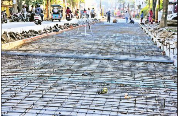
रामगंगा विहार में स्मार्ट सिटी के तहत चल रहा सड़क का निर्माण कार्य। ● अमृत विचार
