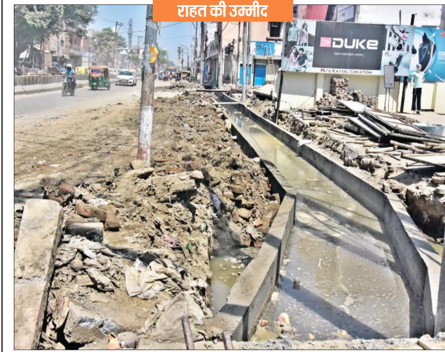
कांट रोड पर स्मार्ट सिटी योजना के तहत किया जा रहा नाला निर्माण का कार्य।
