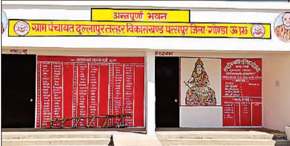
परसपुर ब्लॉक के दुल्लापुर तरहर में बना अन्नपूर्णा भवन।
