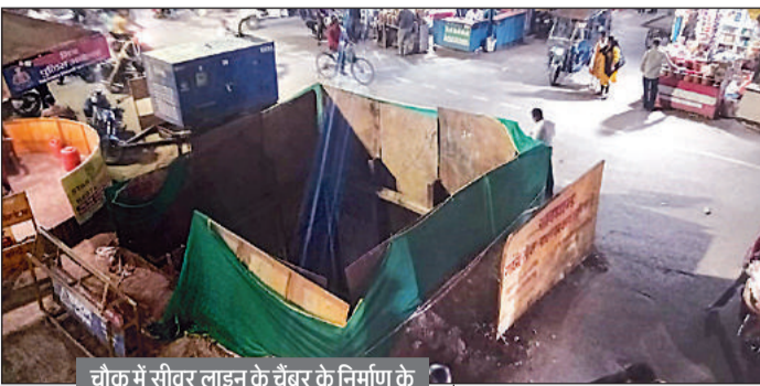
चौक में सीवर लाइन के चैंबर के निर्माण के लिए बैरिकेड लगा किया जा रहा कार्य।
