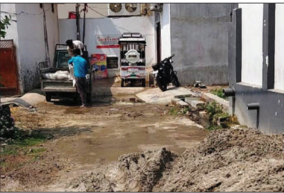
आदर्शपुरम कॉलोनी में सड़क और नाली निर्माण के लिए मंगाई गई सामग्री।
