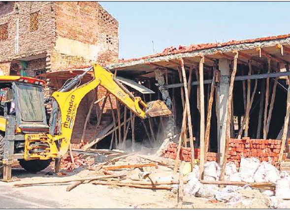
शहर में नाले पर अवैध रूप से किए गए निर्माण को ढहाती जैसीबी।
