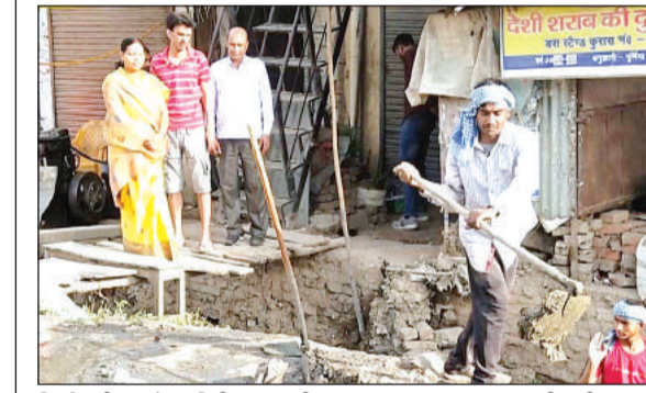
निर्माणाधीन नाले का निरीक्षण करतीं नगर पंचायत अध्यक्ष आशा रानी कबीर।
