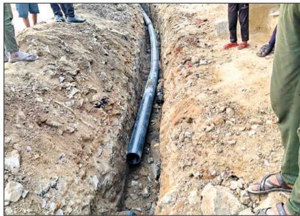
सायर गांव में नमामि गंगे की डाली जा रही पाइप लाइन।
