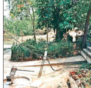
पौथिया गांव के एसवी इंटर कॉलेज के अंदर टूटा पड़ा बिजली का पोल।
