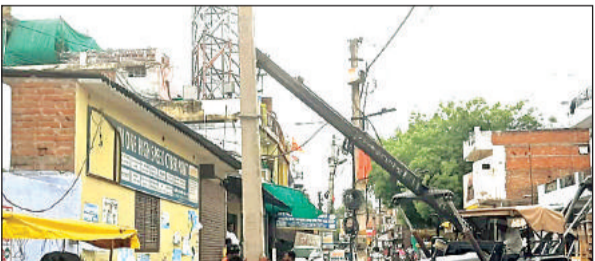
बिजली के खंभों को सड़क किनारे लगाती मशीन।
