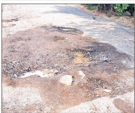
चौफुला चौराहे से कठघरिया जाने वाली सड़क में पेयजल लाइन लीकेज होने से टूटी पड़ी सड़क और गौड़ घड़ा में बंदहाल सड़क का हाल। • अमृत विचार
