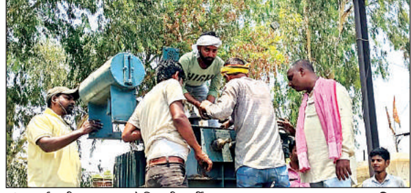
ट्रांसफार्मर की मरम्मत करते बिजली कर्मी।
