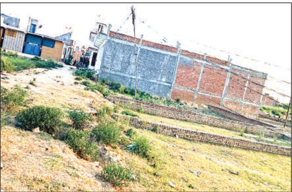
निर्मला नगर में बिजली सप्लाई के लिए बिछाए गये तार।
