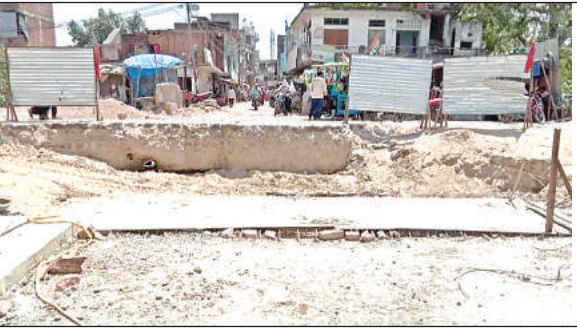
सिठमरा में निचली रामगंगा नहर में सड़क से नीचे बनता पुल ।
