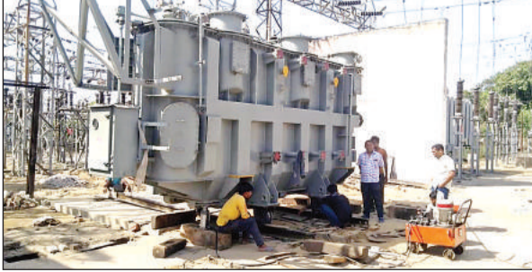
मकरंदनगर सेंटर में ट्रांसफार्मर स्थापित करते इंजीनियर व कर्मचारी।
