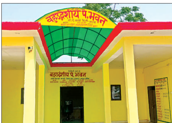
नवनिर्मित व निर्माणाधीन बहुउद्देशीय पंचायत भवन।
